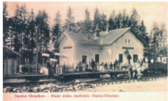
Stavba Obrataně - Místní dráha Jindřichov Hradce-Obrataně.
